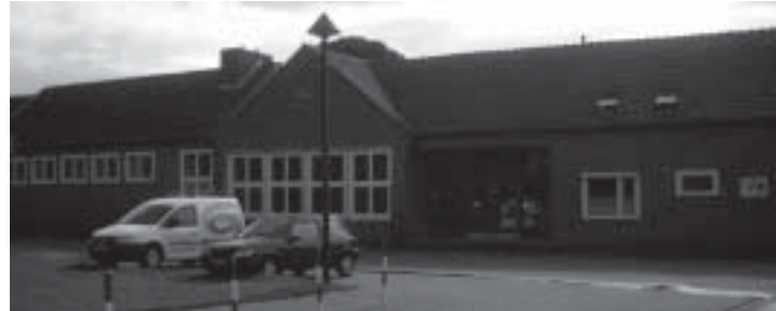
In einem Monat ist dieser Anblick Vergangenheit. Der alte Schultrakt wird in den Herbstferien abgerissen
