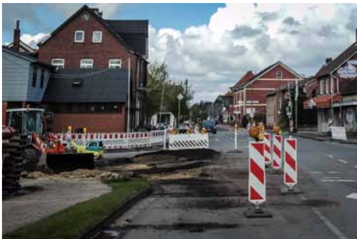
Beginn der Tiefbauarbeiten
